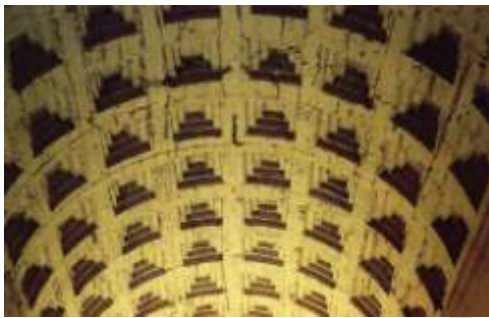
Ilustración 93. Bóveda del vestíbulo.
