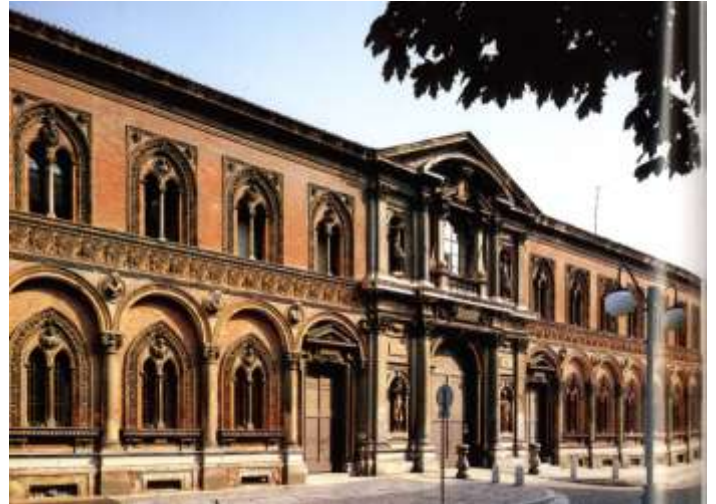
Ilustración 77. Fachada del Hospital de Milán.
